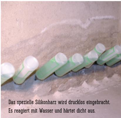
Das spezielle Silikonharz wird drucklos eingebracht. Es reagiert mit Wasser und härtet dicht aus.
