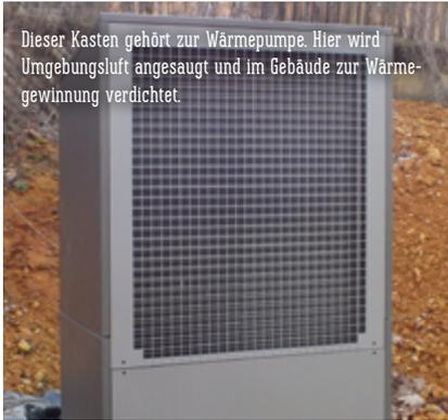
Dieser Kasten gehört zur Wärmepumpe. Hier wird Umgebungsluft angesaugt und im Gebäude zur Wärme-gewinnung verdichtet.
